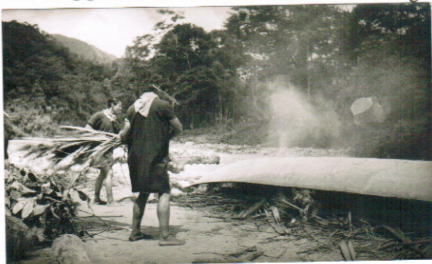
Guillermo und Cristobal beim Bau und Ausbrennen eines 11 Meter langen Einbaumes. Der fertig gestellte Einbaum wird zuvor mit Pflöcken geweitet.
