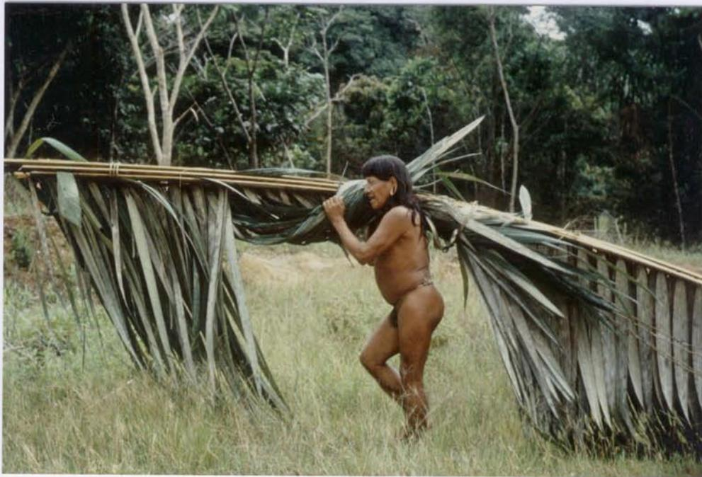
Für den Hausbau werden lange Palmwedel herangeschafft. Sie stammen von der Canambo-Palme (*Scheelea* sp.), einem fast 30 Meter hohen schlanken Baum mit sehr breiten Blattspindeln. Diese werden der Länge nach auseinandergetrennt und damit das Haus gedeckt.
