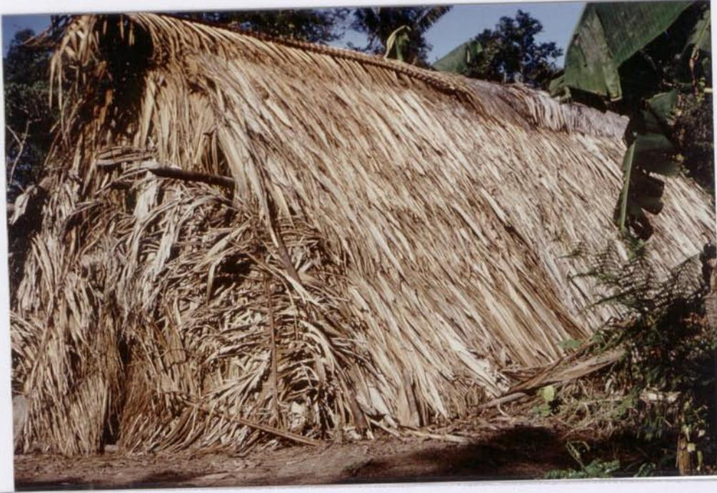
Das Auka-Haus ist im Grundriß rechteckig; meist sechs mal acht oder acht mal zehn Meter. Der robuste Bau wird von schlanken Baumstämmen getragen. Das mächtige, nach außen gewölbte Dach des Sippenhauses ruht auf diesen Stämmen, an denen die Palmblattlagen mit reißfesten Lianen angebunden werden.
